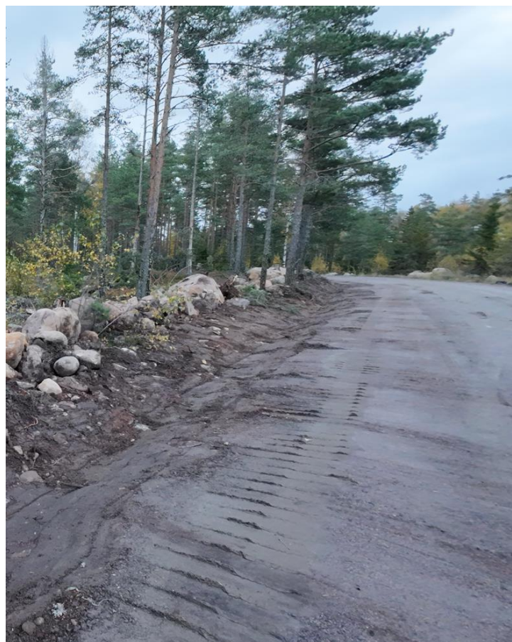
BILD 14 OPTOWEST FÖRBÄTTRADE BL.A. DIKEN OCH PLACERADE STENARNA UTANFÖR KÖRBANAN ENLIGT AVTAL, VILKET GJORDE ATT PLACERINGSLOVEN IGEN ÄR LÄTTARE ATT FÅ – ÅTMINSTONE FÖR OSS.
