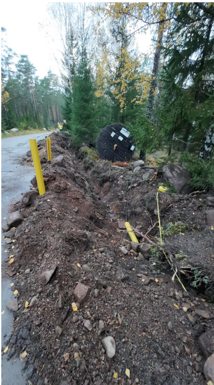
BILD 15 PADVAVÄGEN: UNDER ARBETETS GÅNG SÅG DET UT SÅ HÄR.
