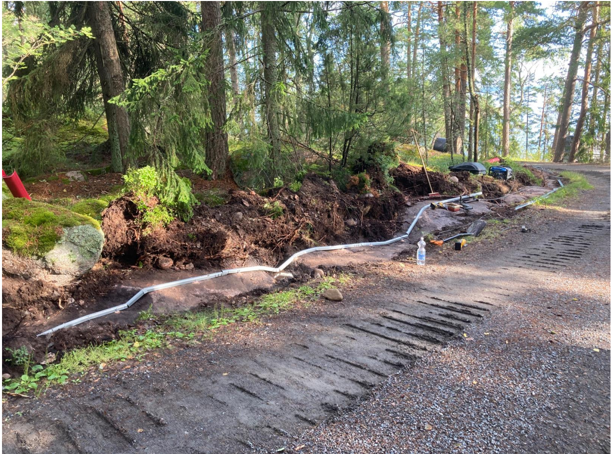
BILD 16 ÖVÄGEN UNDER ARBETE.
