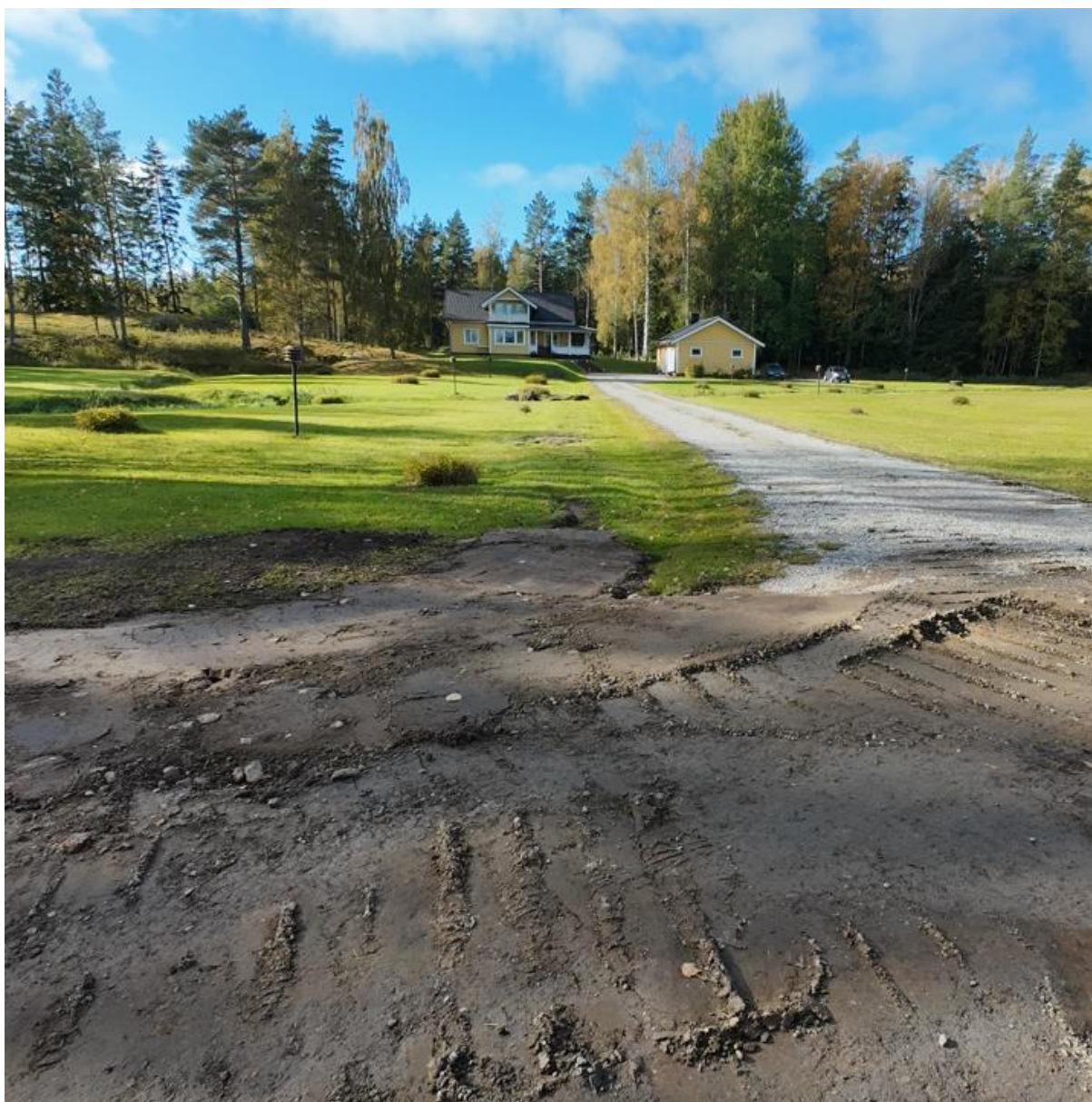
BILD 3 ORVLAXVÄGEN: FTTH (FIBER TO THE HOME) - VISST SYNS DET ATT FIBERKABELN BLEV DRAGEN UPP TILL Huset ALLDELES NYSS?
