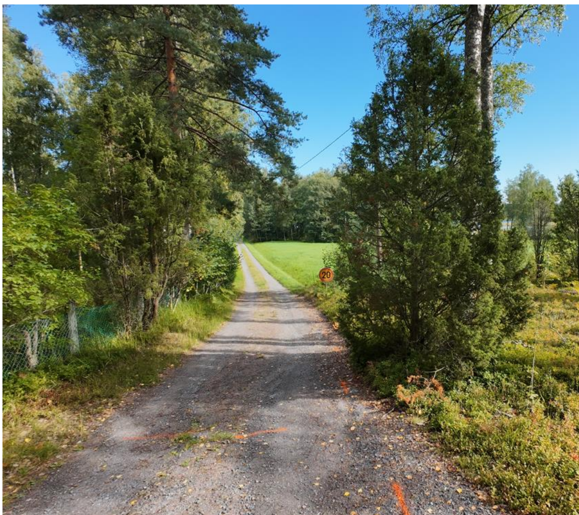
BILD 7 ORVLAXVÄGENS UTMANINGAR. FIBERKABELN SKALL PLOGAS NER 70 CM, FÖRBI DE SKYDDADE ENARNAS RÖTTER, UTAN ATT FÖRSTÖRA VÄGEN, UTAN ATT GÅ IN PÅ GRANNARNAS TOMTER OCH SAMTIDIGT FÖRSÖKA HÅLLA HASTIGHETSBEGRÄNSNINGEN!
