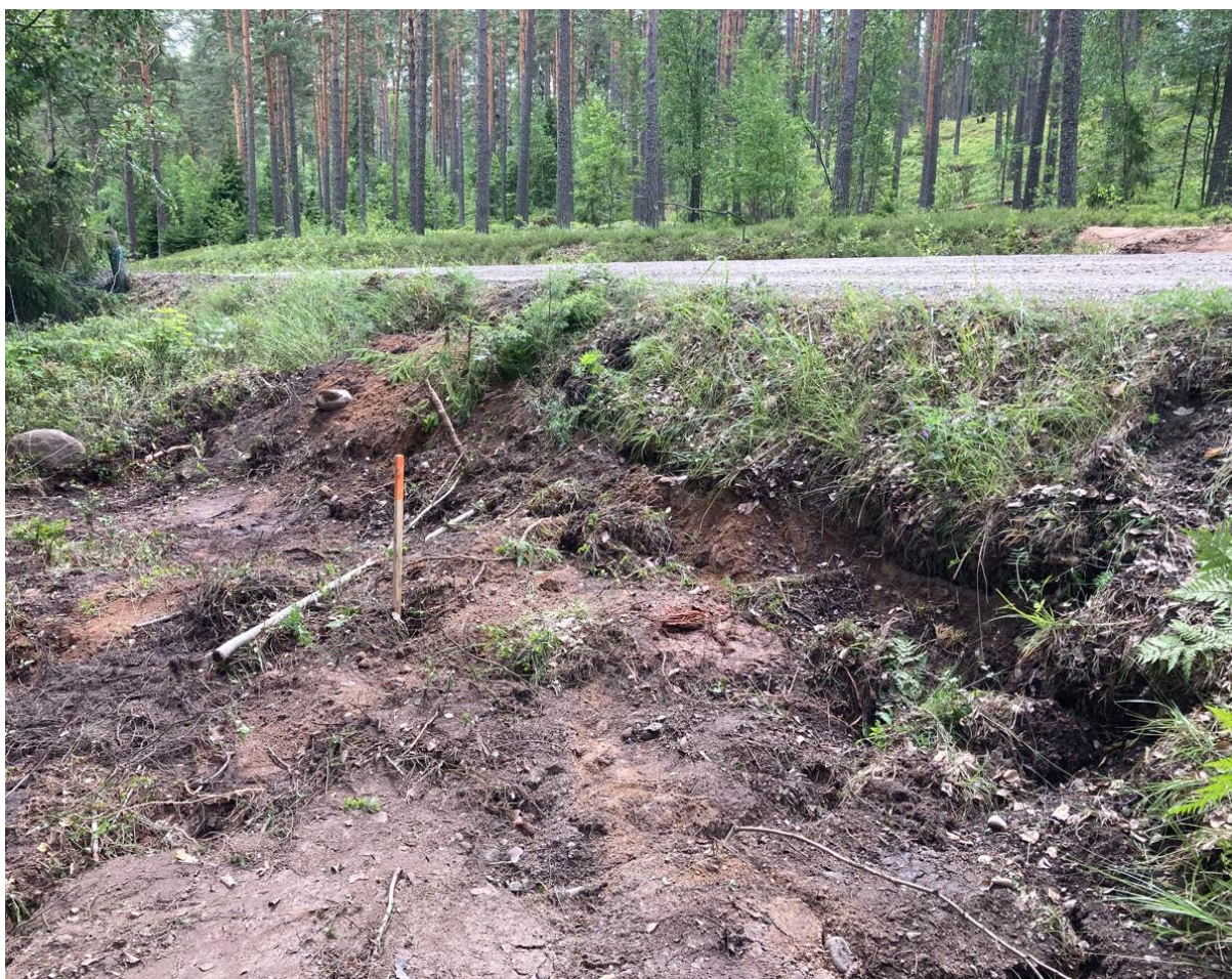
BILD 8 PÅ BILDEN SYNS INTE 100MM-RÖRET, SOM ÄR BORRAT UNDER ORVLAXVÄGEN OCH UTMÄRKT MED ORANGEMÅLAD KÄPP. SLANGEN, SOM SYNS PÅ BILD, GÅR OCKSÅ GÅR UNDER VÄGEN, MEN TILLHÖR INTE PROJEKTET.
