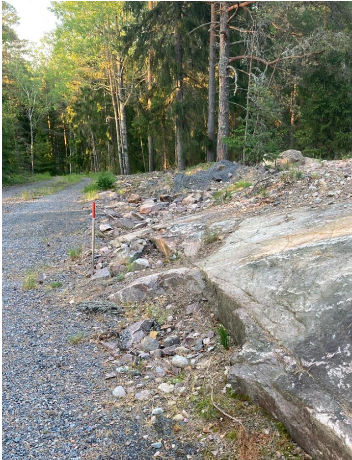
BILD 13 HELA PROJEKTOMRÅDET: BILDEN VISAR VARFÖR DET VAR SVÅRT ATT FÅ PLACERINGSLOV ATT DRA FIBERKABLAR. FÖREGÅENDE KABELDRAGARE BRYDDE SIG INTE SÄRSKILT MYCKET OM ATT PUTSA UPP I DIKET EFTER SIG.
