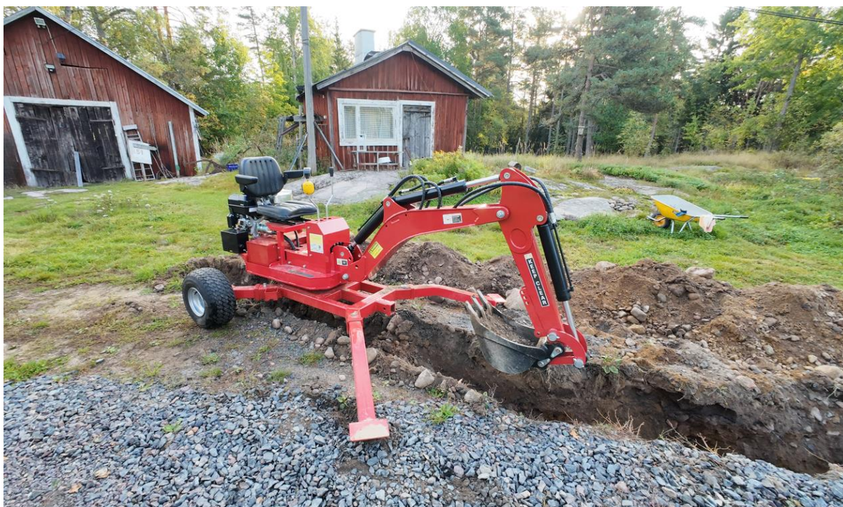
BILD 6 FASTIGHETSÄGARE PÅ KALVDALSVÄGEN GRÄVER FIBER.
